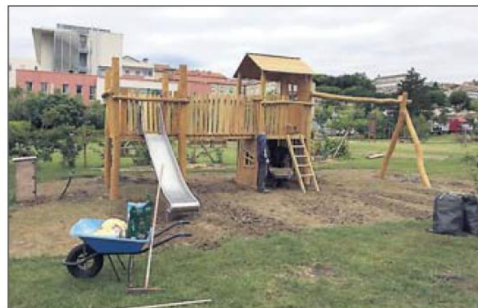
► Lors de l'installation des jeux. / Photo DDM.
